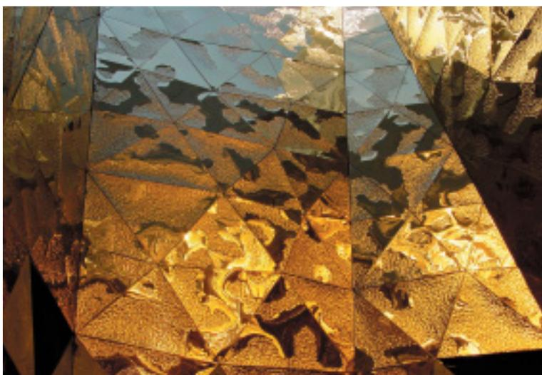
*En la pequeña capilla, los paneles triangulares de acero inoxidable presentan un pertinente fulgor dorado. El acabado se consiguió mediante la deposición de vapor con nitrato de potasio.*
