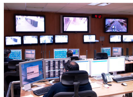
Centro de Control
