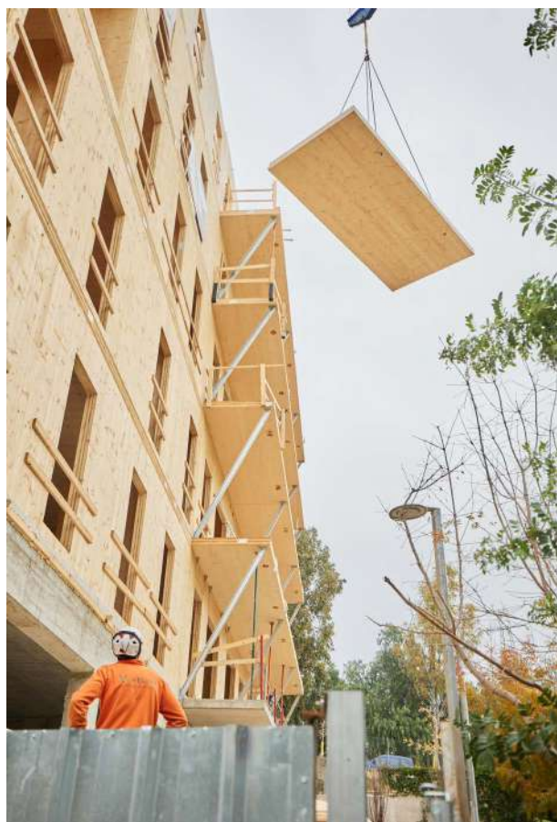
Construcción del proyecto Cirerers de vivienda cooperativa.
