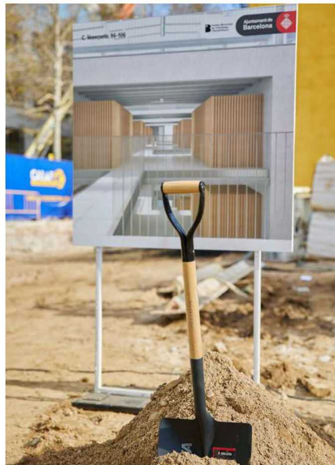
Solar en obras destinado a vivienda pública
