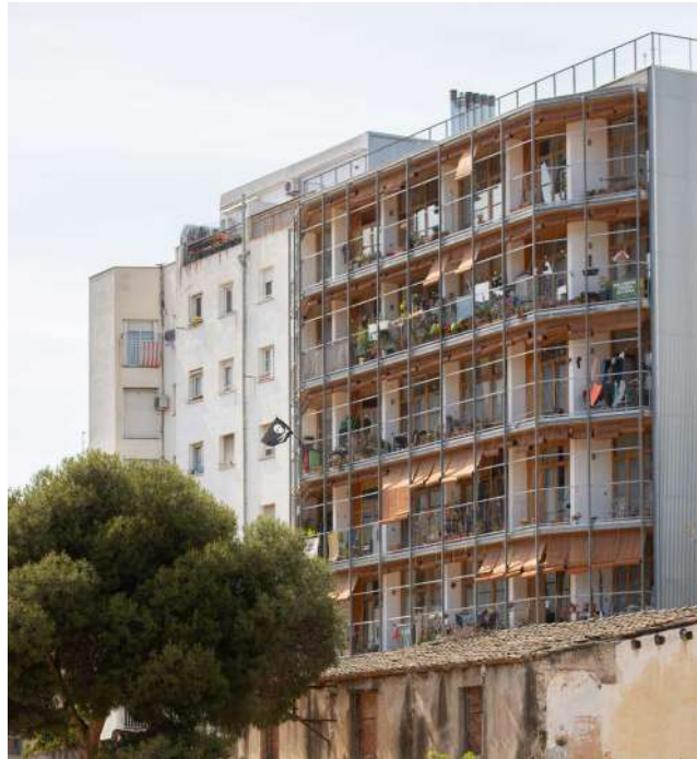
Fachada de la promoción de vivienda cooperativa de La Borda
