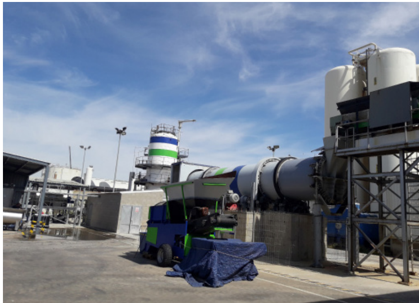
Complejo para Tratamiento de Residuos Urbanos
